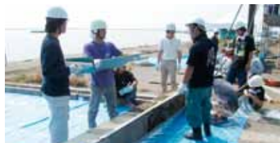
海洋環境に暴露したシラスコンクリート試験体の調査状況
