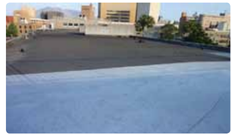
遮熱塗料 光触媒複合塗料を屋上面に塗布することによる、遮熱効果を検証した
