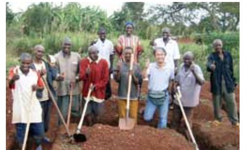
「償いのプロジェクト」着工翌日の建設現場にて
